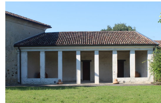
Vista 14 - Edificio D
