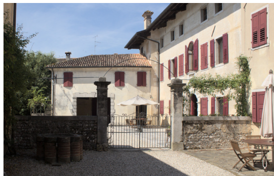
§ Vista 2 - Edificio A
