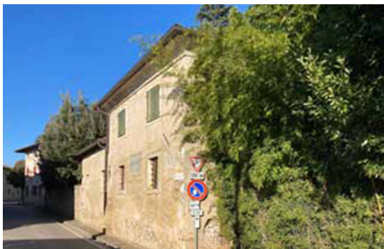
§ Vista 18 - Edificio E
