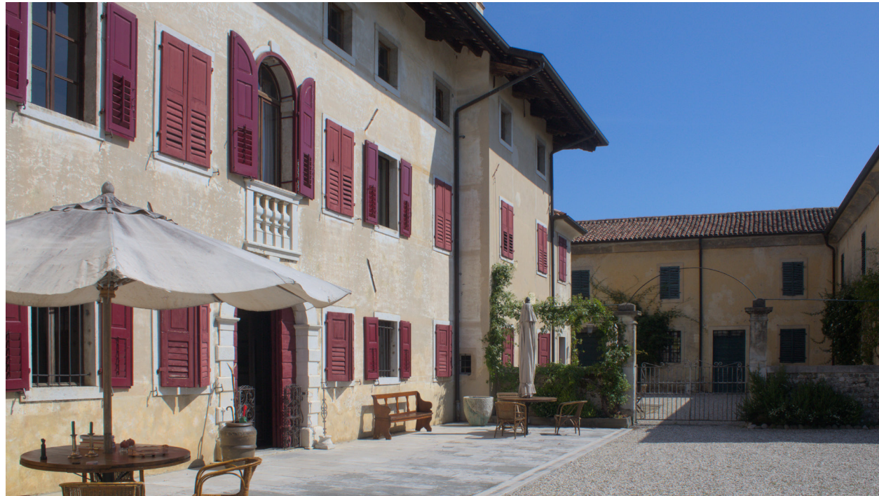
∞ Vista 1 - Edificio A
